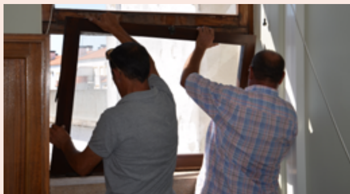
NISA Reparação de janela no Tribunal de Nisa
