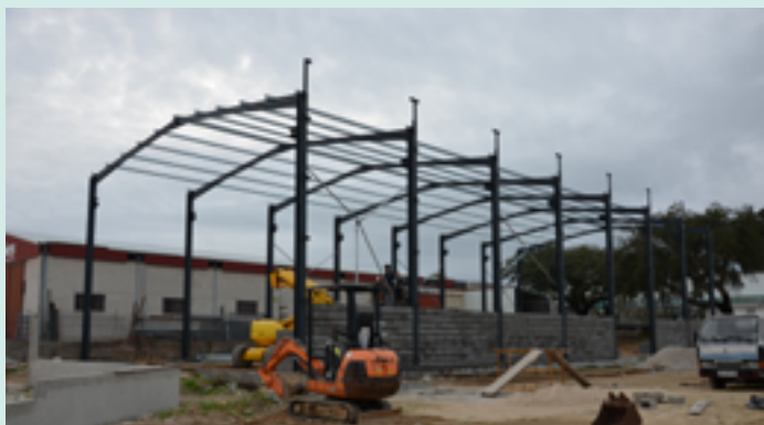
Ampliação da empresa "Serralharia Camões"
