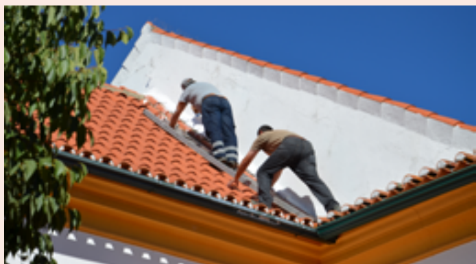
NISA Reparação de infiltrações no telhado da Igreja Matriz
