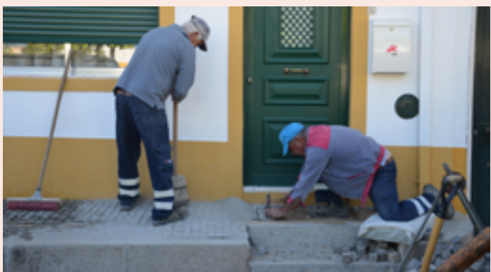
NISA Colocação de calçada no Largo Heliodoro Salgado
