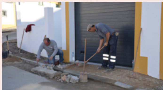
NISA Colocação de calçada no Bairro da Cevadeira
