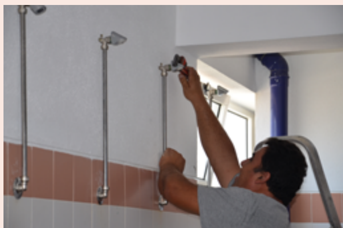
NISA Substituição de chuveiros no Pavilhão Municipal
