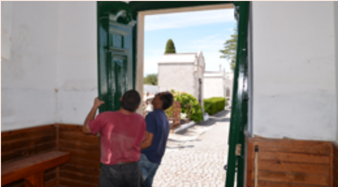
NISA Restauro das portas de entrada da capela mortuária e execução de novos bancos de apoio
