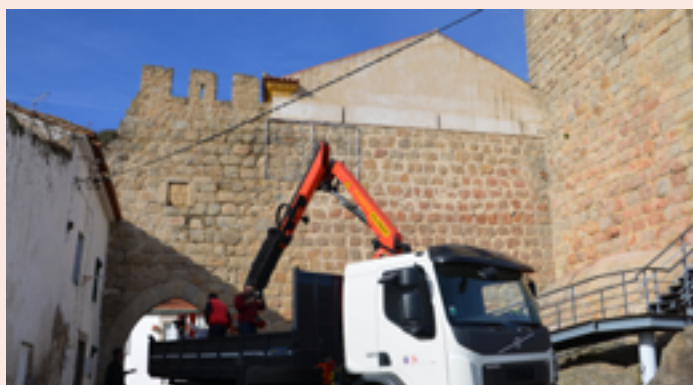
NISA Colocação de iluminações de Natal
