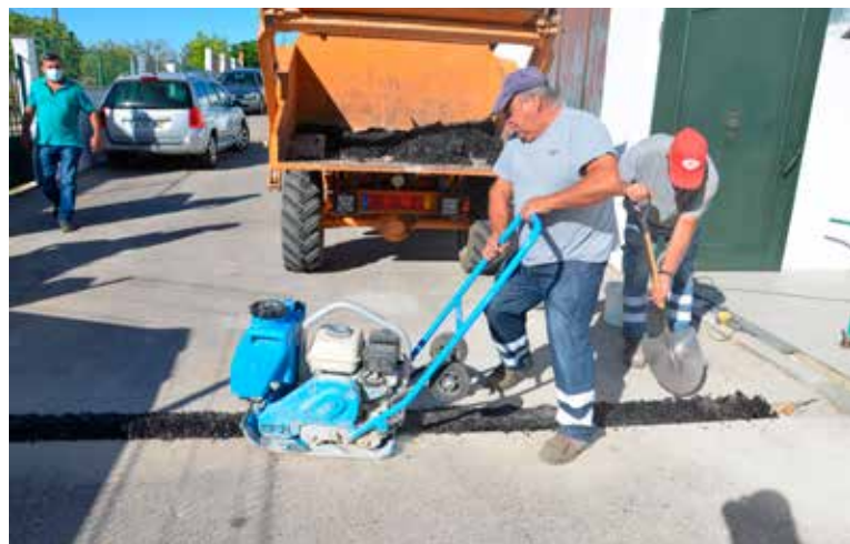
NISA Colocação de betuminoso
