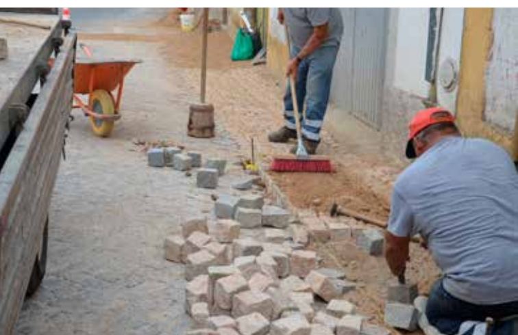
NISA Reposição de Calçada
