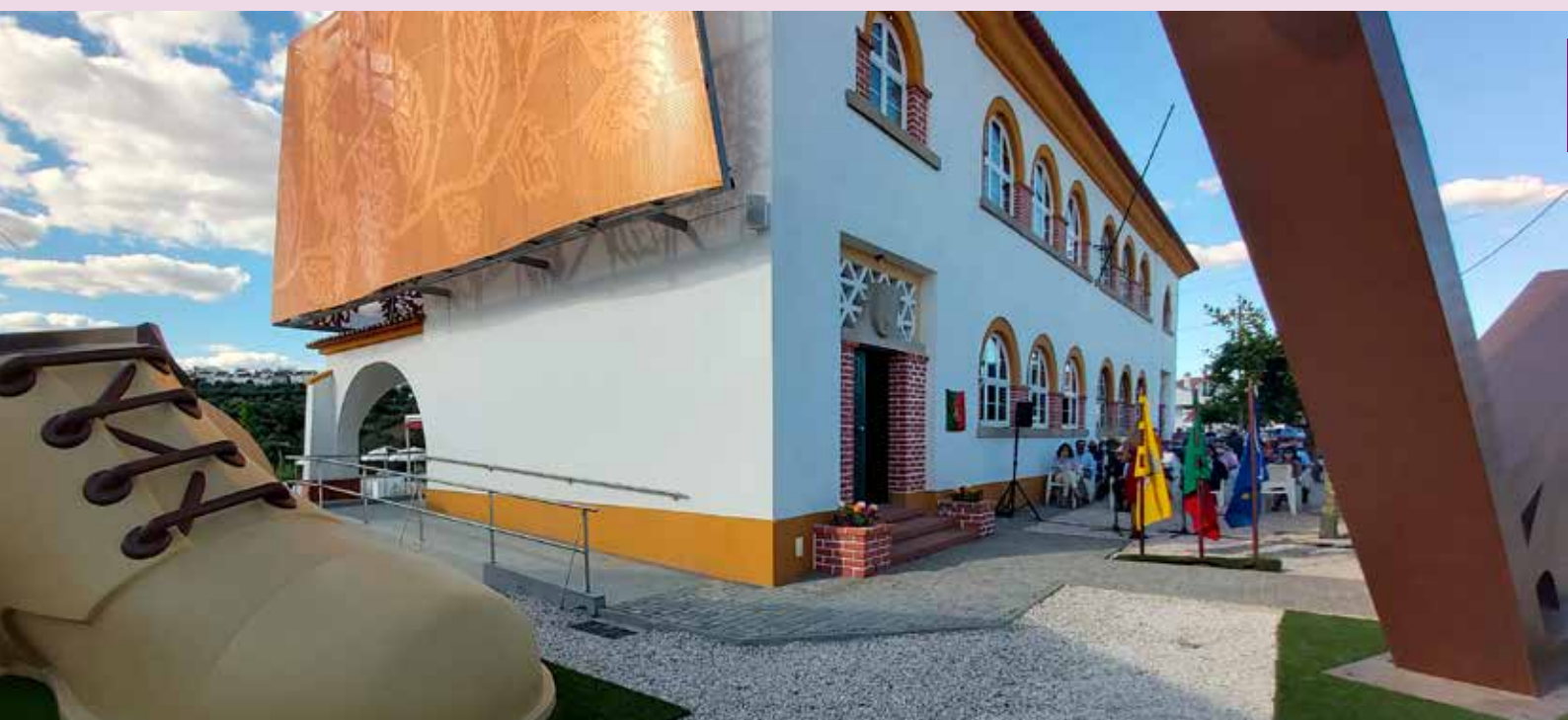
MONTALVÃO - Montalvão "Vintage" Valorização e Recuperação da Escola Primária
