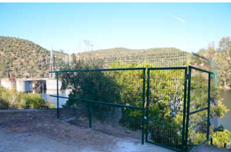
MONTALVÃO Instalação de estrutura de proteção no acesso ao cais da Barragem de Cedillo
