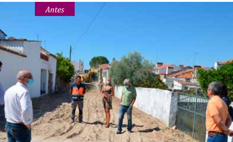
ALPALHÃO Rua n.º3
