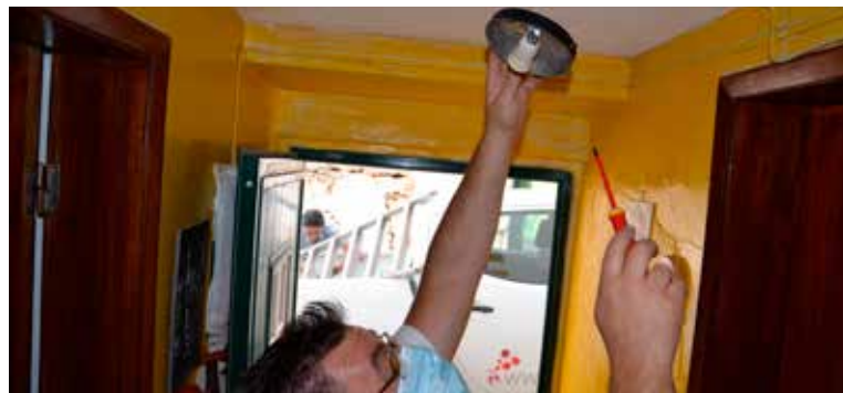
Oficina Móvel - Reparações elétricas
