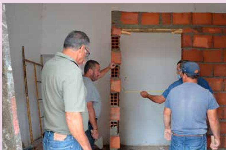
TOLOSA Cedência de mão-de-obra em construção de WC no Cemitério
