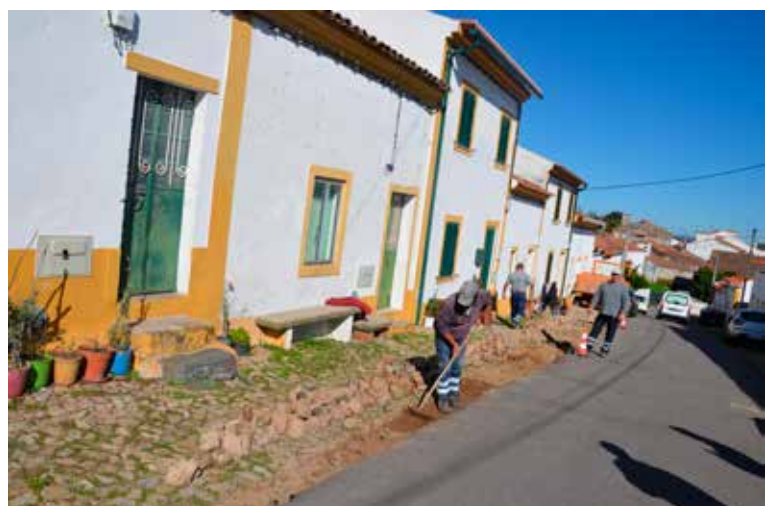
FALAGUEIRA Reposição de Calçada
