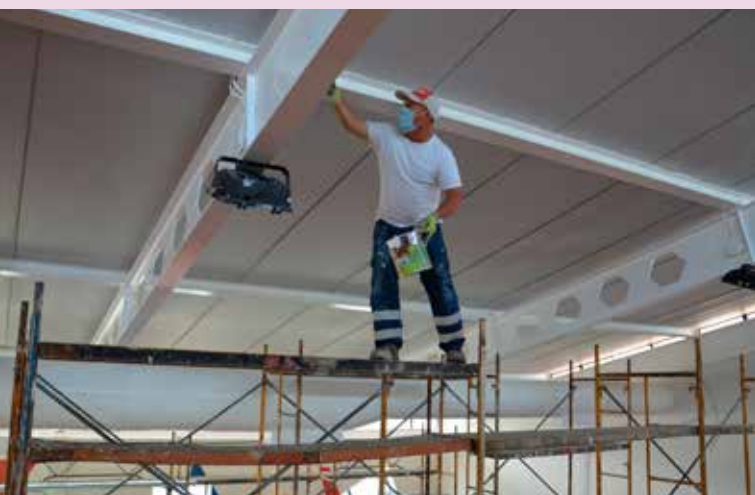
NISA Pintura da nave da Piscina Interior
