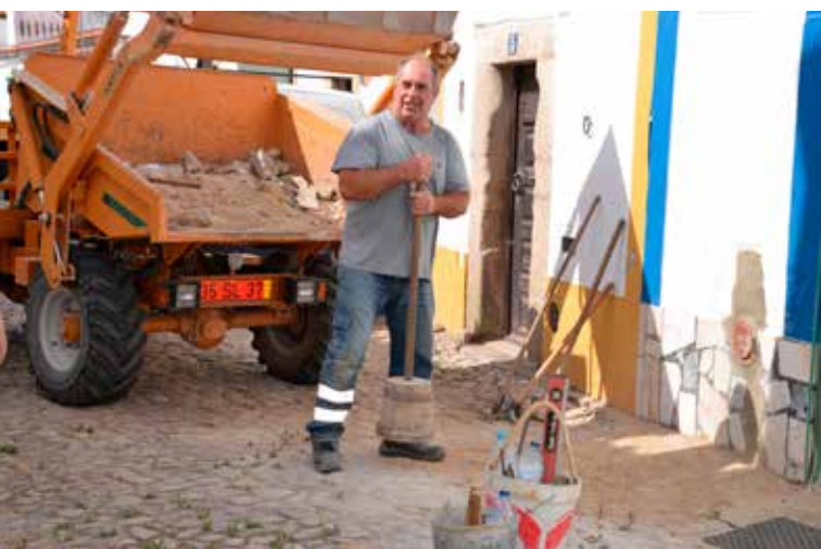
ALPALHÃO Reposição de Calçada
