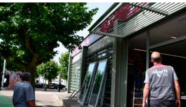
NISA Substituição de porta no Posto de Turismo
