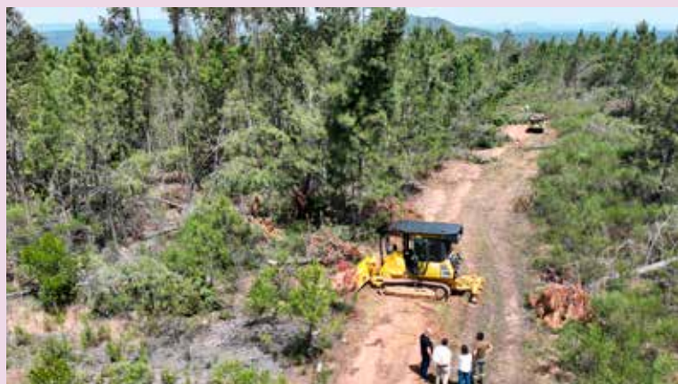
Limpeza de acessos na Serra de S. Miguel
