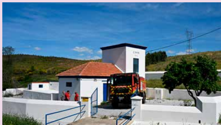
Teste do Reservatório da Galeana para apoio ao combate a incêndios
