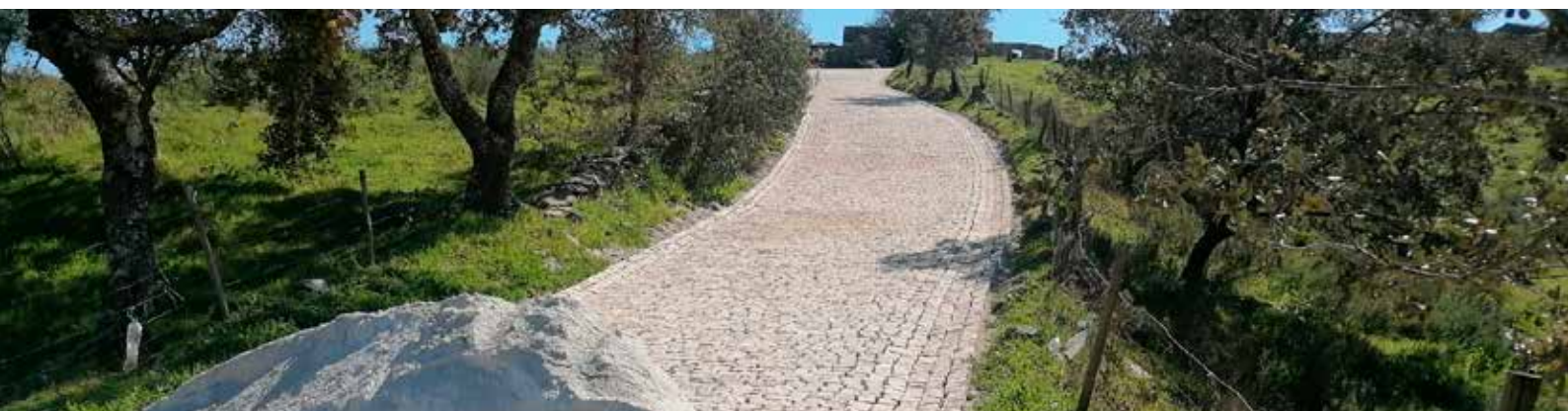
CHÃO DA VELHA - Beneficiação do Caminho de Acesso ao Cais Fluvial do Chão da Velha Valor Contratado: 88.470,00€
