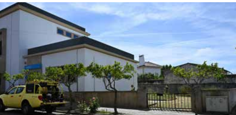
Limpeza no espaço exterior do Tribunal de Nisa
