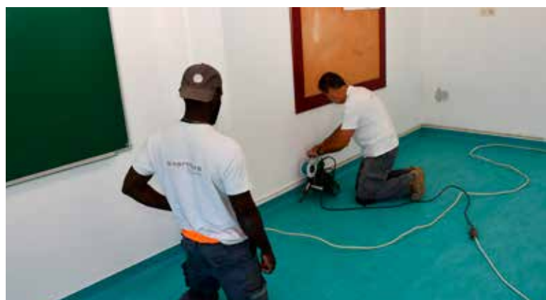
NISA – Renovação do Bloco B da antiga escola
