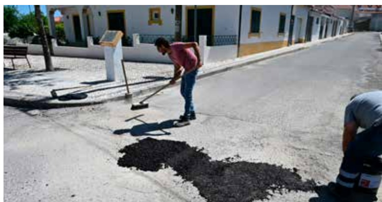
NISA – Colocação de massas frias
