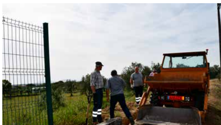
NISA Colocação de gradeamento no Campo de Jogos
