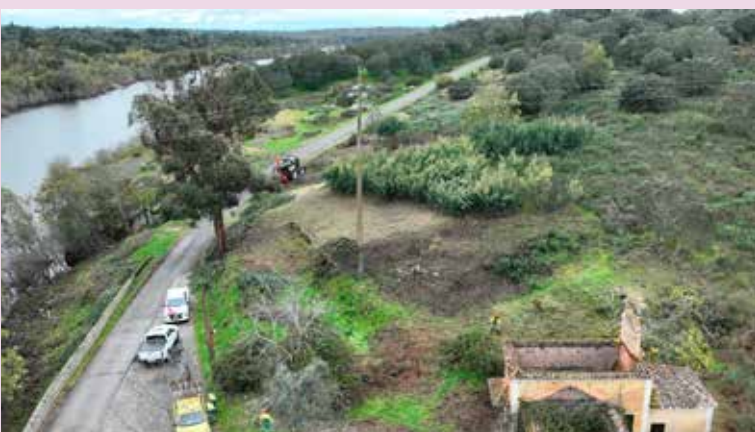
Limpeza das Redes Primárias de Faixas de Gestão de Combustível
